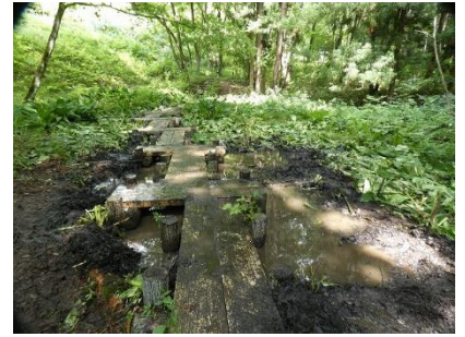
カエル池 (浚渫後)
